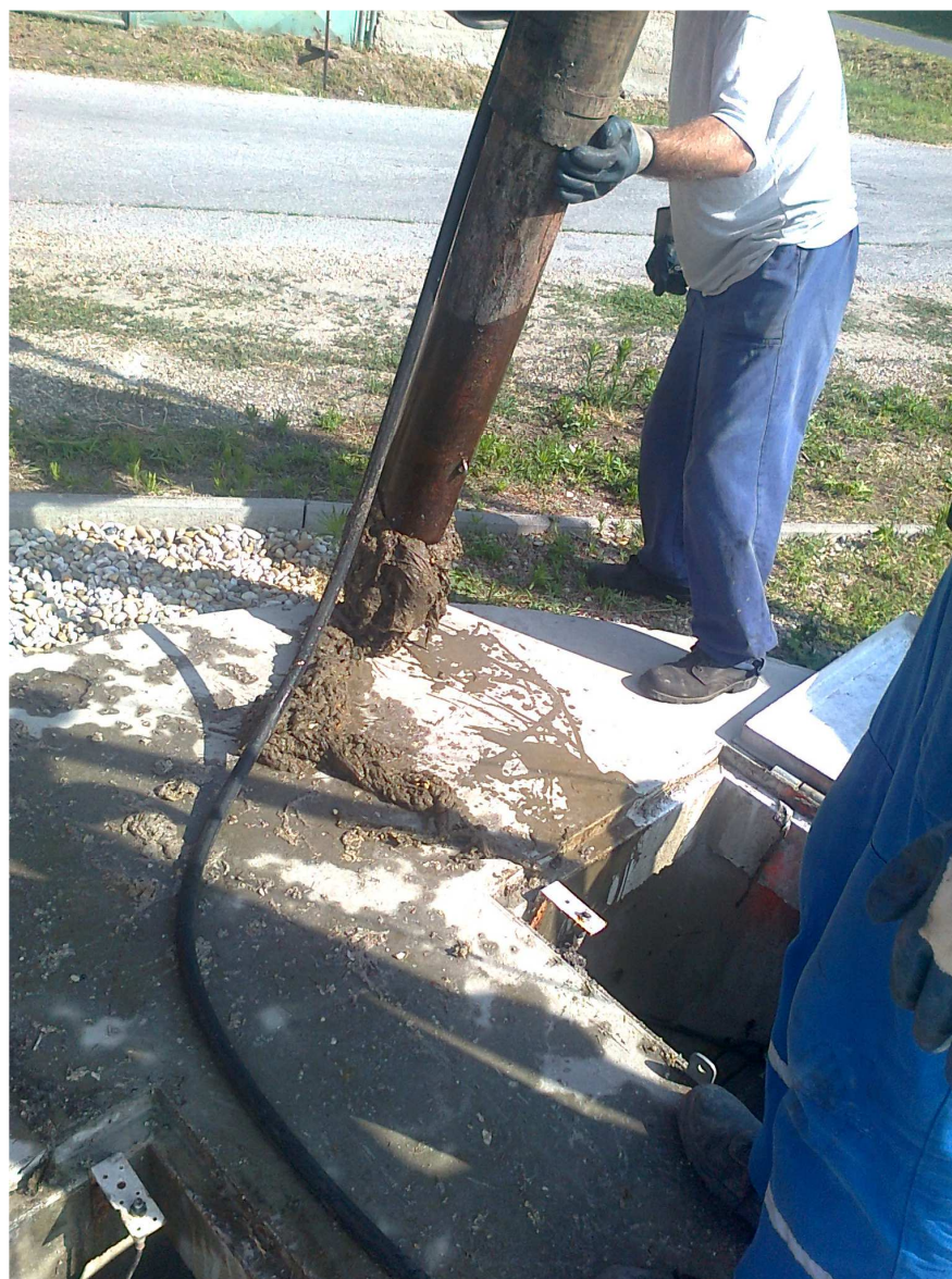
Čistenie čerpacej stanice so sacím vozidlom
