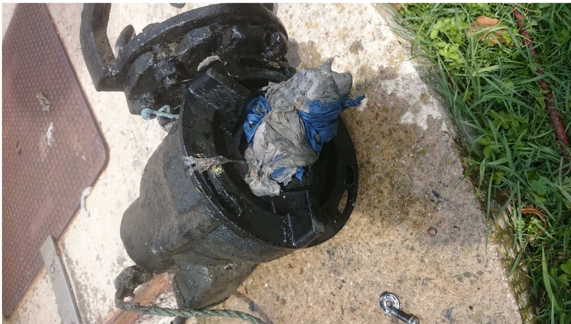
Upchané čerpadlo
