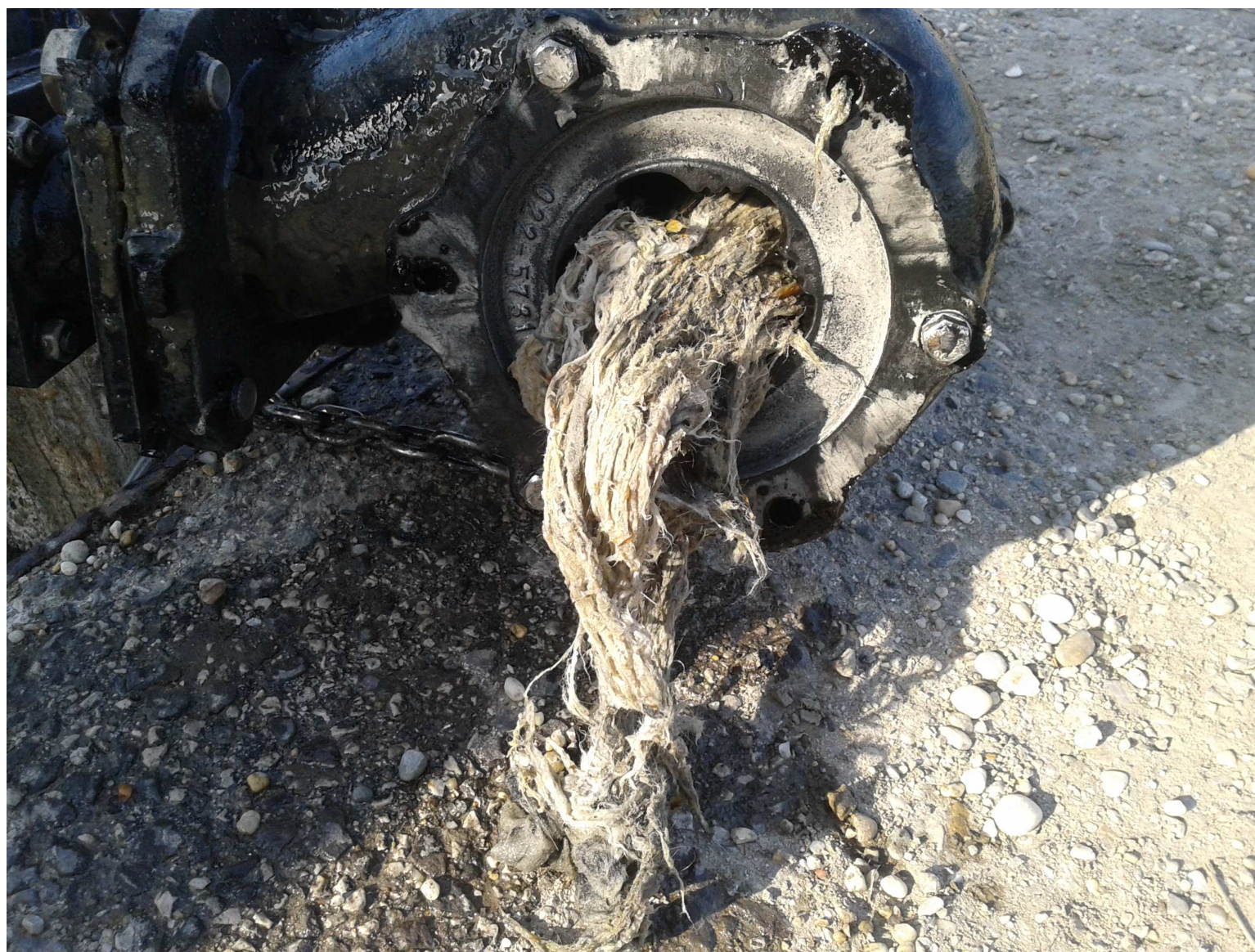
Upchané čerpadlo vlhčenými obrůskami
