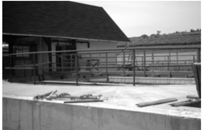
Snímka zachytáva celkový pohľad na areál stavby ČOV tesne pred dokončením
