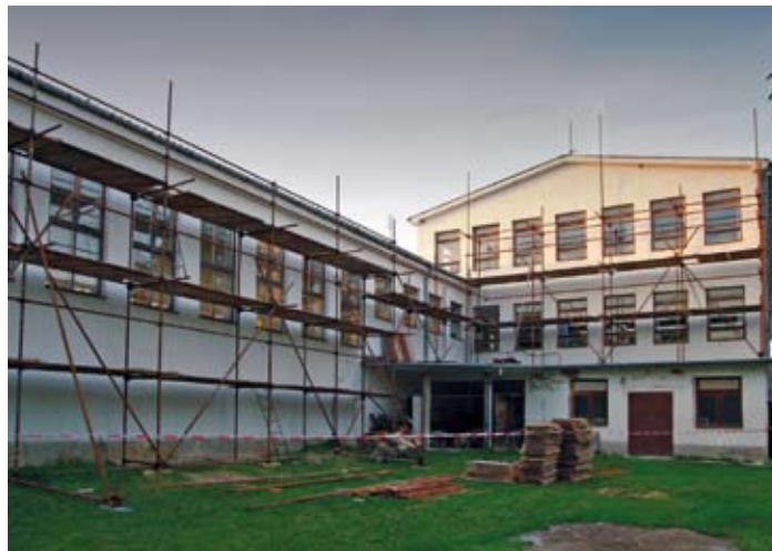
1. júna začali prebiehať prípravné práce k rekonštrukcii. Nasledujúce dva mesiace sa uskutoční hlavná časť rekonštrukcie budovy ZŠ (kotelňa, výmena okien a zateplovanie). Autor fotografie: Ing. Miloslav Brandt
